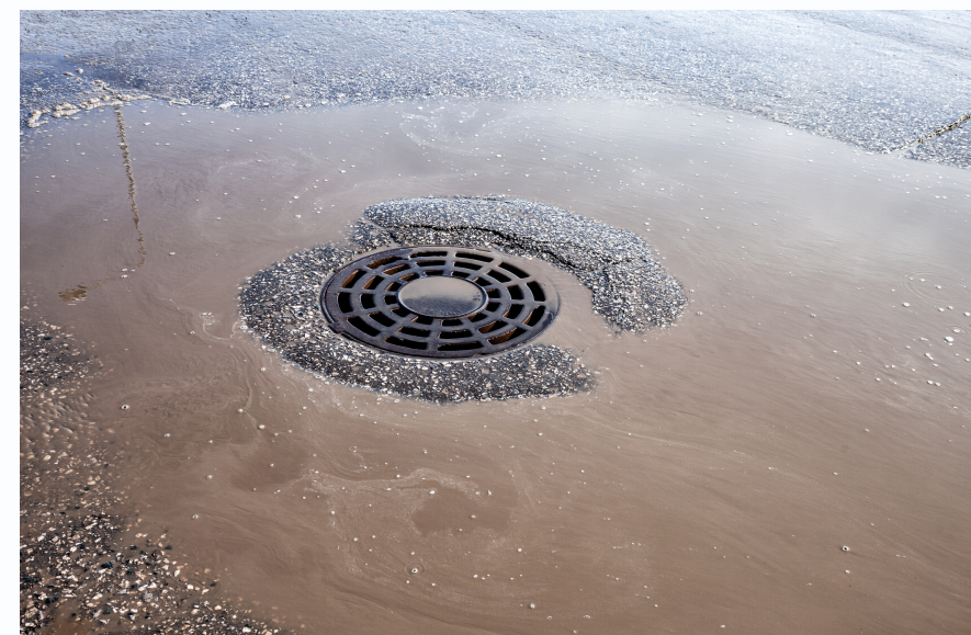
DRENAGEM DA CHUVA
